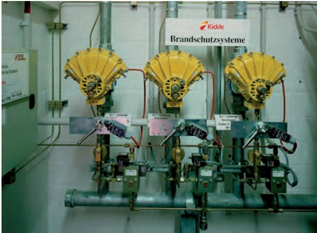
Bereichsventile für Hochdrucklöschanlagen
