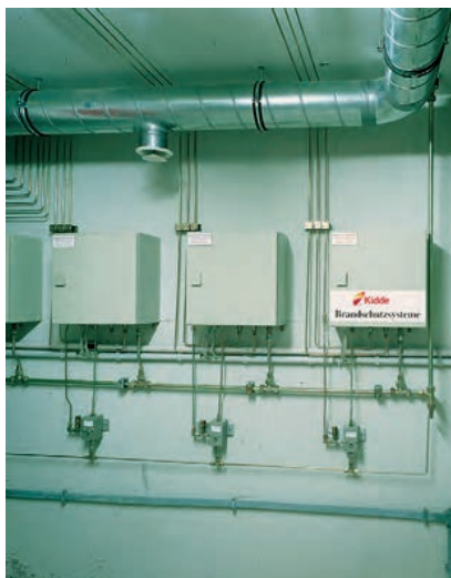
Anordnung von pneumatischen Zeitverzögerungen für 4 Löschbereiche
