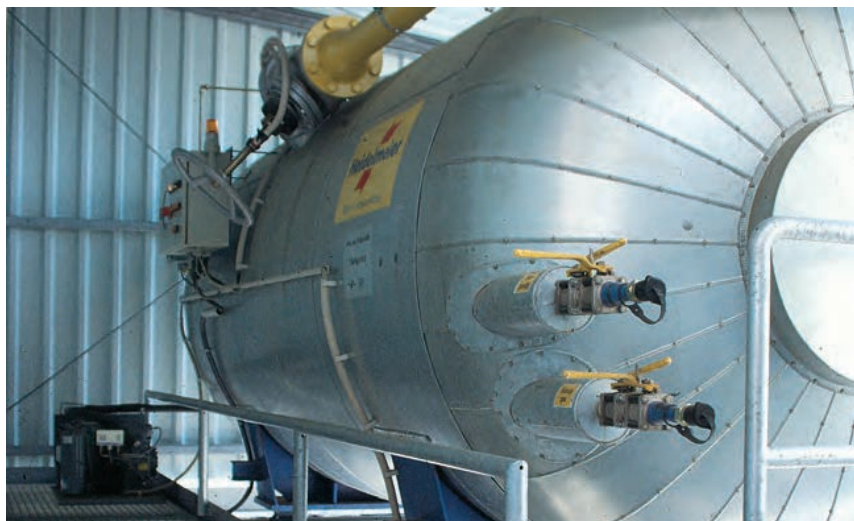
CO 2 -Vorratsbehälter mit elektronischer Wägezelle zur Schwundüberwachung
