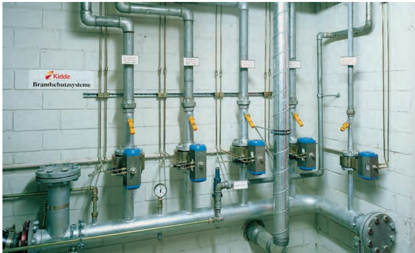
Bereichsventilverteiler für CO 2 -Niederdruckanlagen
